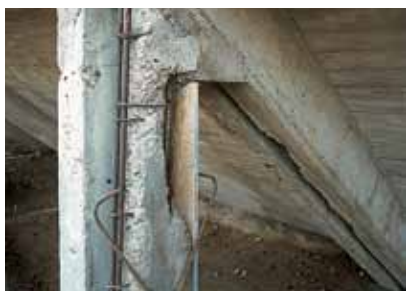
Štěpení betonu na vrstvy
