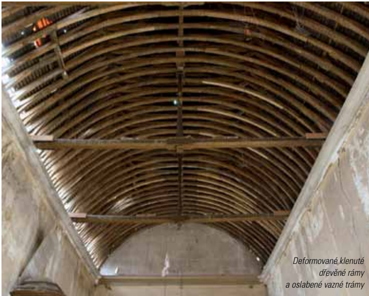
Poškozené dřevěné konstrukce
