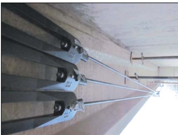
Kotvení trojice lan pomocí kotev 1R15
