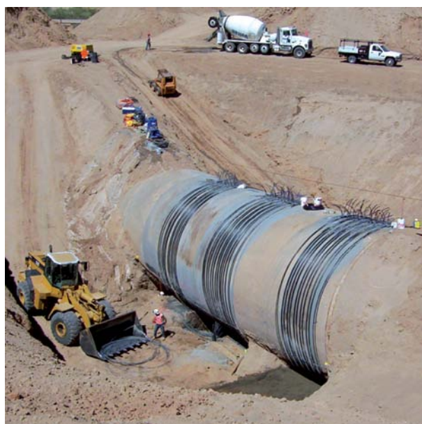
Kotvení pro spínání potrubí - 2X15
