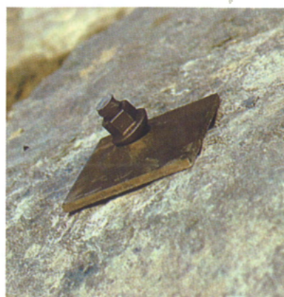
Zpevnění svahu
