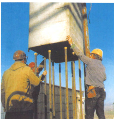
Napojení prefabrikátů
